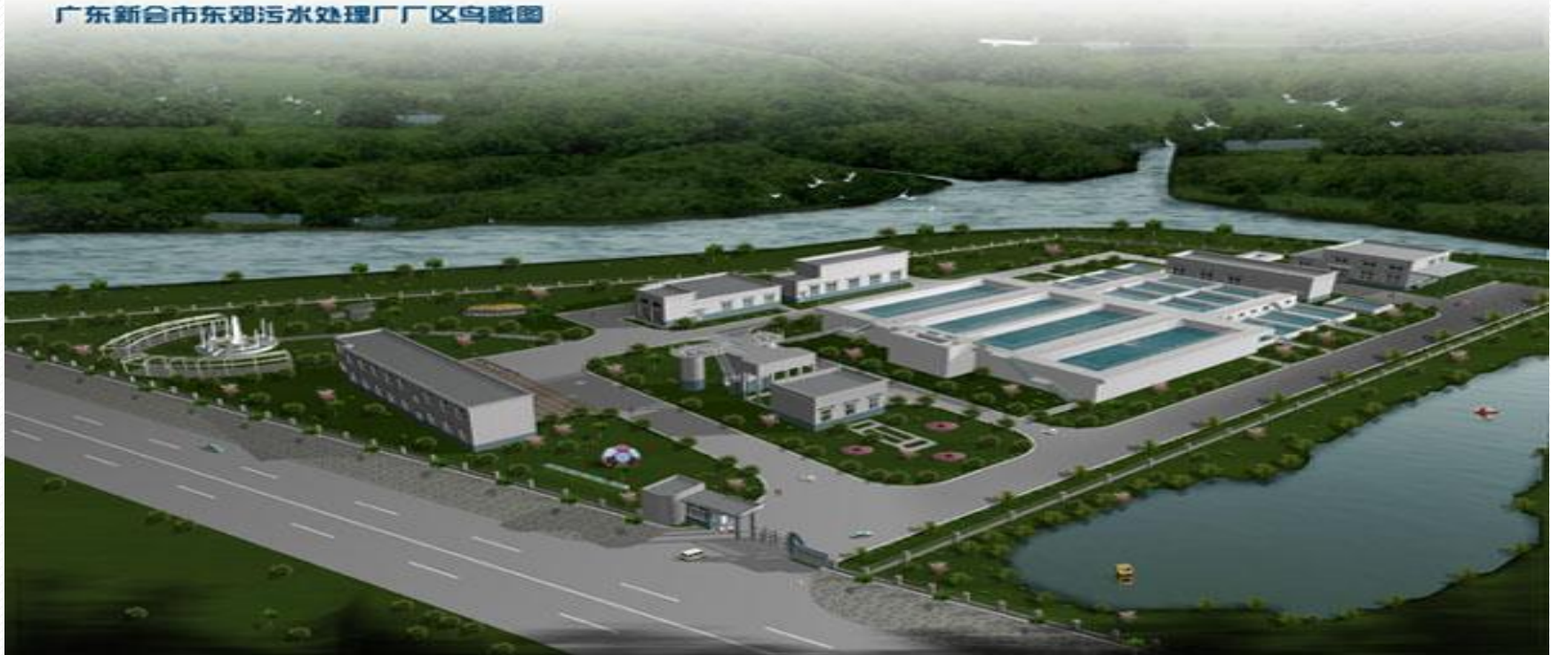
广东新会市东郊污水处理厂厂区鸟瞰图
